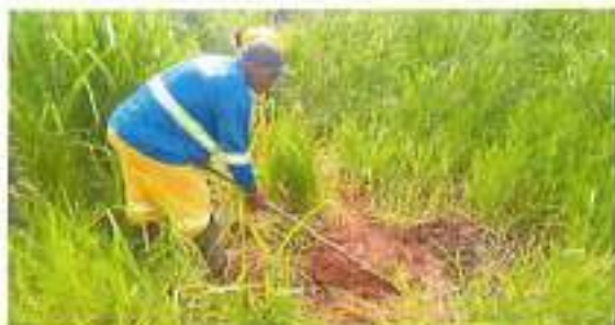
Foto 01 Colaborador realizando atividade de coroamento no subleite em referência (registro fotográfico 14/04/2023).
